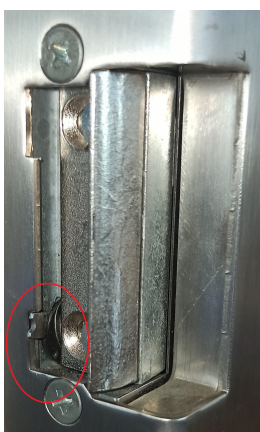
Páčka určená k přepínání elektrozámku do trvale otevřené/uzavřené polohy
